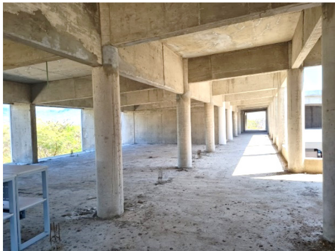
Obra en proceso Unidad de Docencia IV
